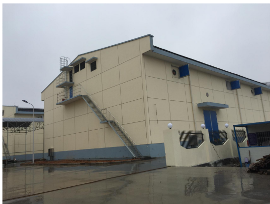
附件：施工现场照片
